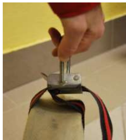
NEPRAVILNO ZAPET CEVNI NOSILEC
